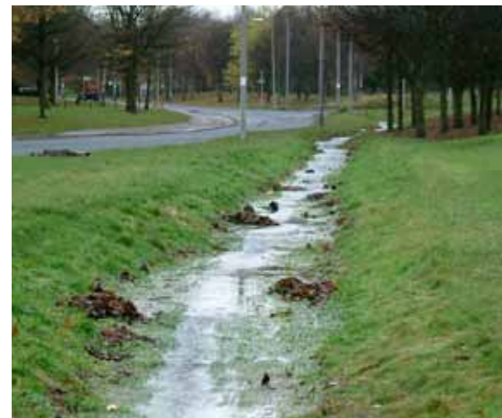
Eksempler på grønne vandrender. Renderne bør anlægges så de er i samspil med landskabets former og beplantning.
