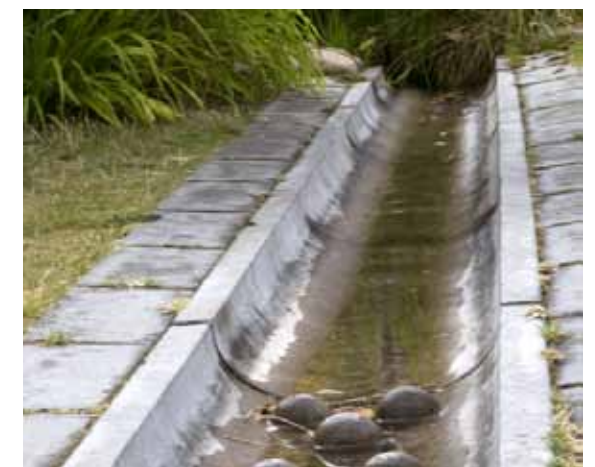
Rende i beton - kan for eksempel bruges langs veje eller stier.
